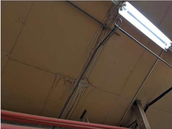
Vesivuotojälkiä sisäpinnoilla
