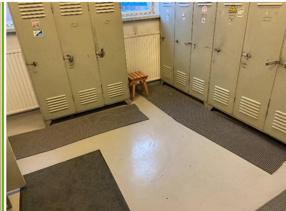
Pukuhuoneessa maalattu betonilattia
