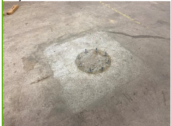
Rakentamisajankohdan jälkeen valettu antura laitejalustalle
