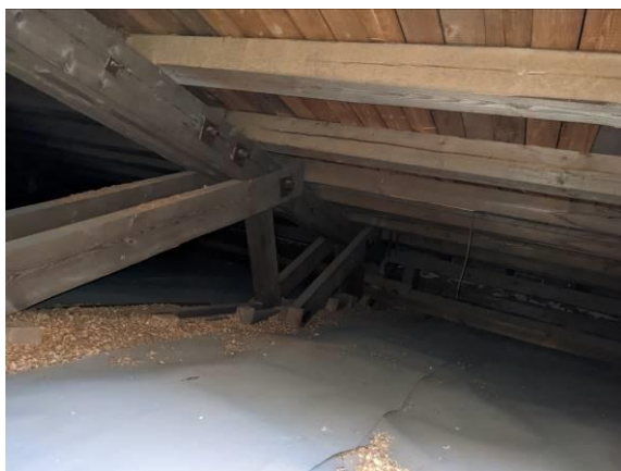
Yleiskuva yläpohjasta räystäään suuntaan
