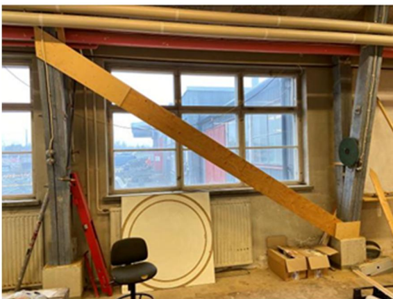
Halkeilevia kehiä tuettu hallista
