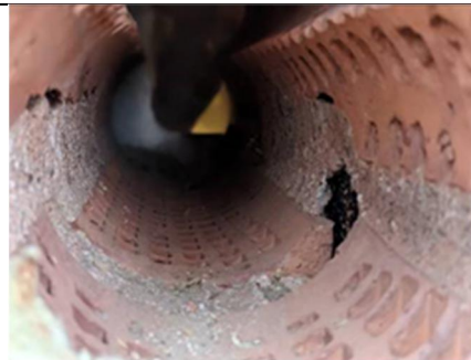
Rakenneavaus RA.12-US.02 ja mikrobinäytteet, ulkoseinärakenne päädyissä betonipilarien kohdalla
