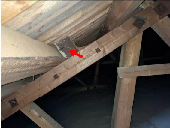
Orret vääntyneet, halkeamat syvällä
