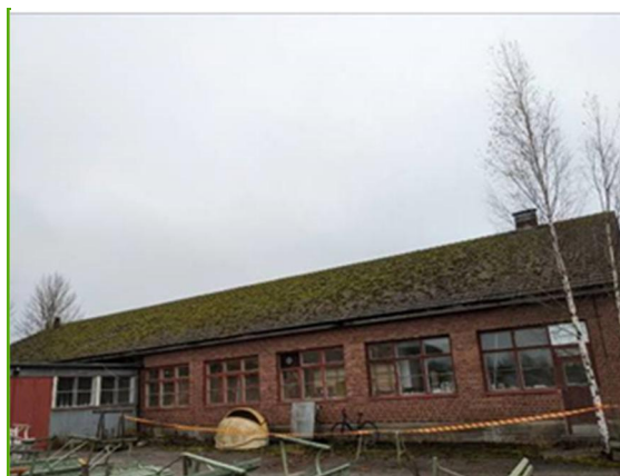
Yleiskuva julkisivusta länteen
