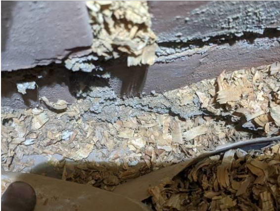
Ilmansulkupahvi nostettu seinäliittymästä jättäen liittymän auki
