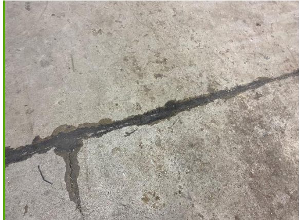
Liikuntasaumaa massattu rakentamisajankohdan jälkeen
