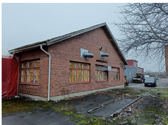
Yleiskuva julkisivusta pohjoispäädyssä
