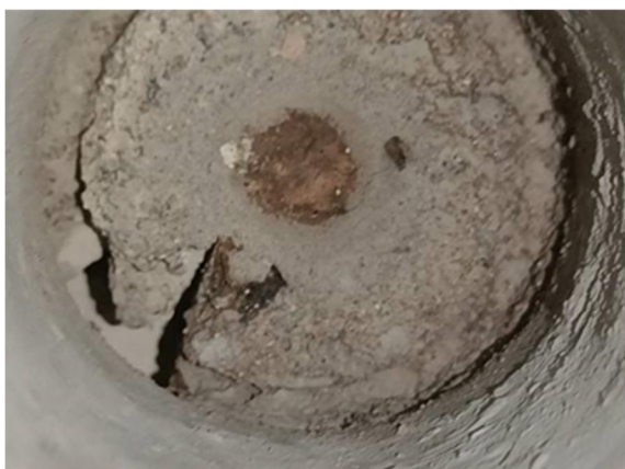
Laastia sokkelibetonin ja tiilen välissä
